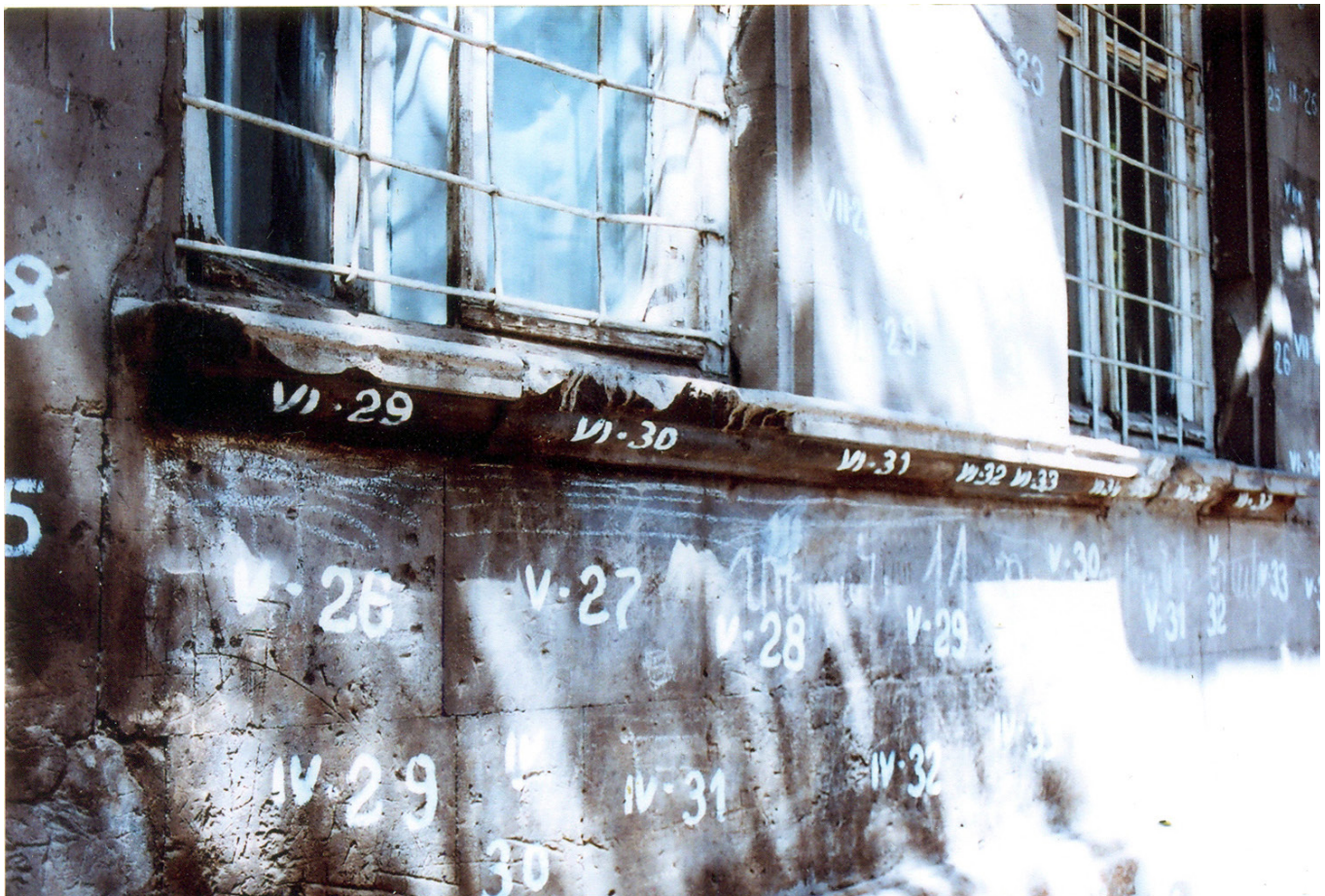
Beispiel für die Nummerierung eines Abbruchhauses und für die Bemalung eines Durchganges, Yerevan, 2012
